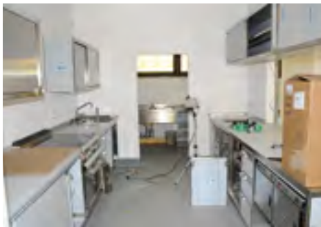
Umbauarbeiten im Pfarrsaal und neuen Küche
